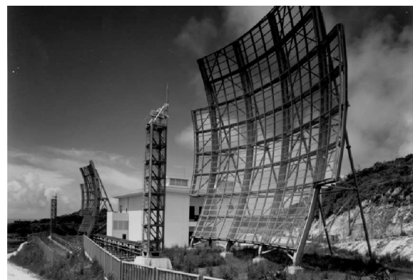
Fig. 13 Backnet antenna.
